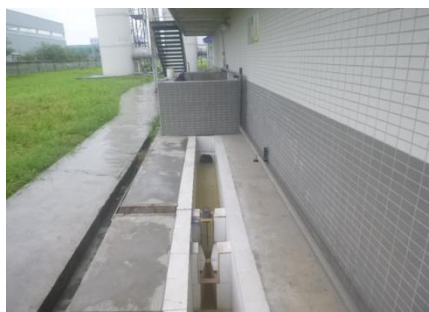
现有污水排口排水现状
