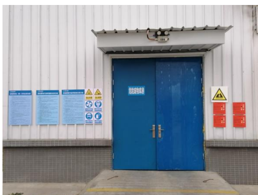
危险废物贮存间
