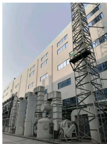
2#车间废气处理装置
